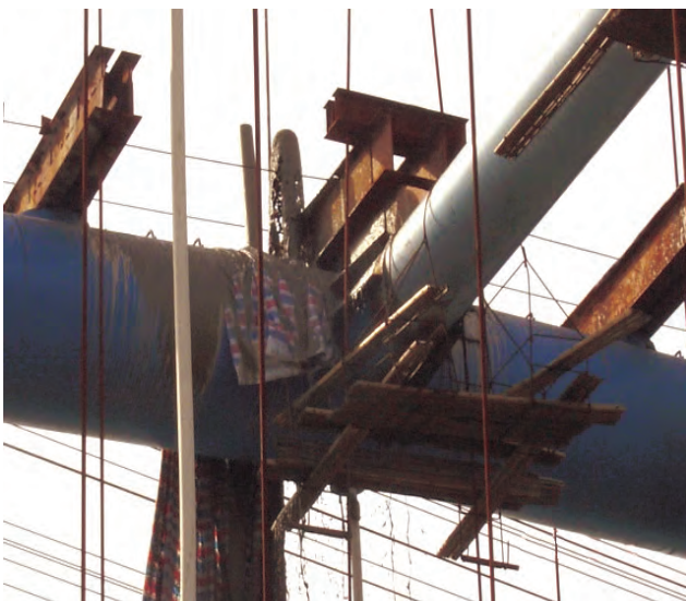
彩图18 灌注钢管拱肋混凝土
