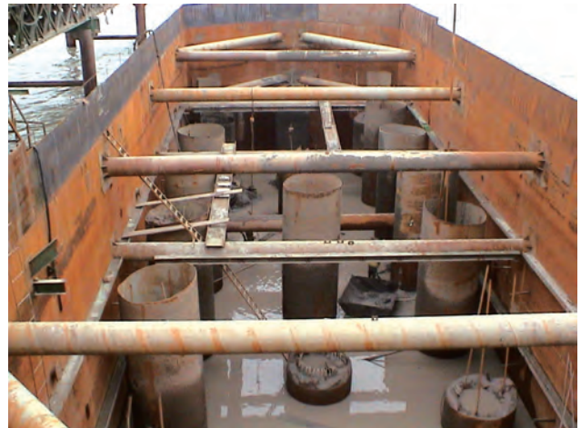
彩图5 钢围堰抽水
