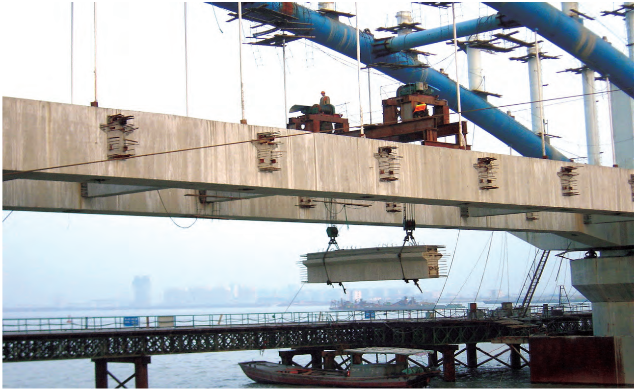
彩图21 安装85m跨系梁间横梁
