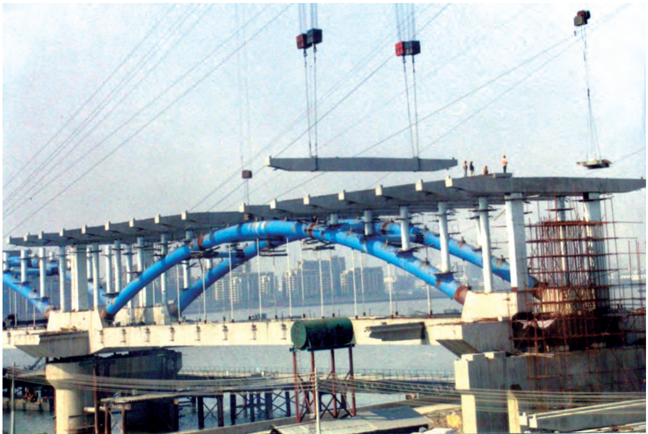
彩图22 安装85m跨拱上横梁
