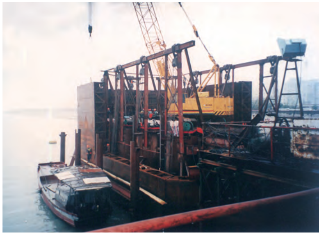
彩图4 施工钢围堰
