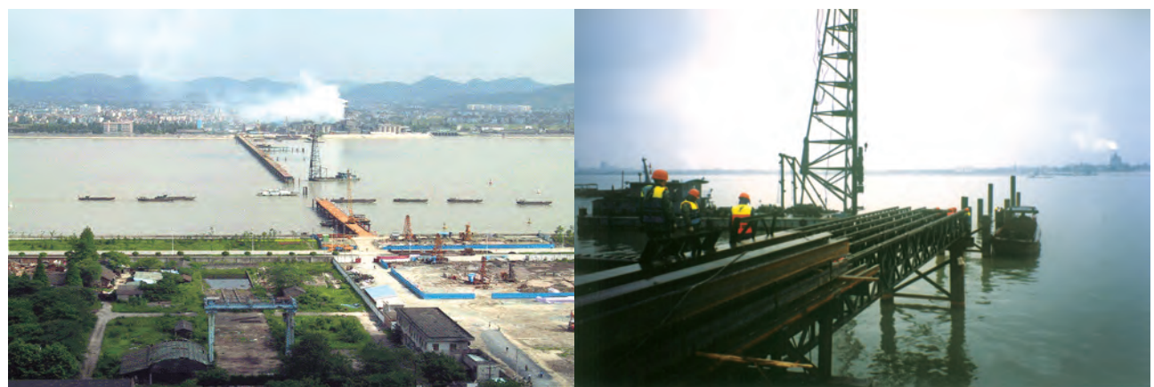
彩图3 施工栈桥
