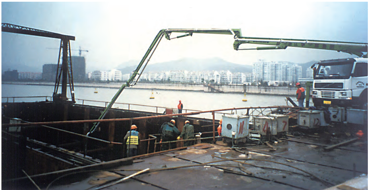
彩图6 钢围堰混凝土封底
