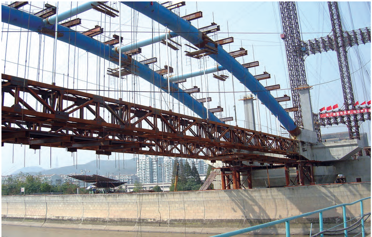
彩图20 施工85m跨系梁劲性骨
