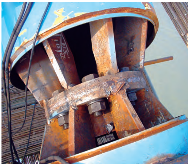
彩图17 拱肋法兰临时连接
