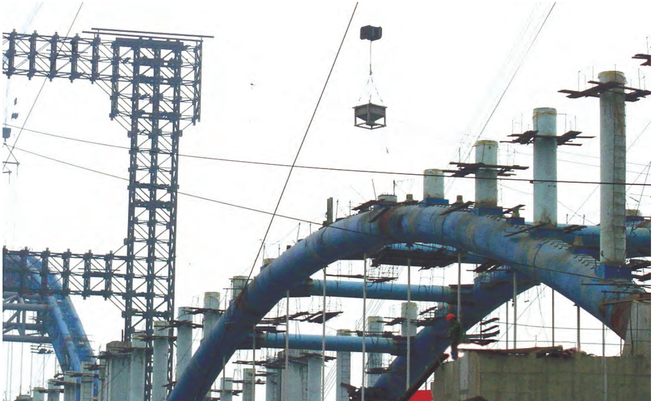
彩图19 灌注拱上立柱混凝土
