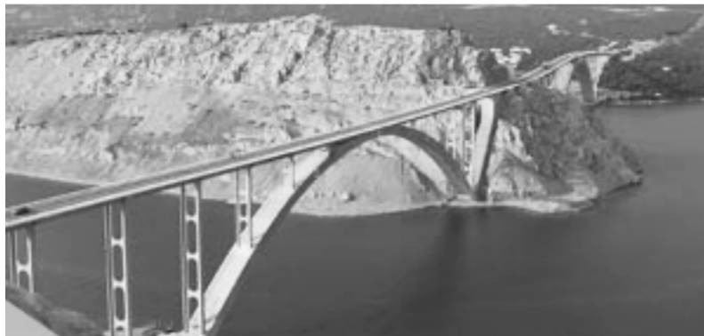
图 1.3-3 克尔克大桥 Figure 1.3-3 KRK Bridge
