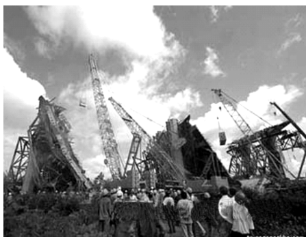
图 1-6 越南建设中芹苴大桥倒塌现场照片(来自互联网)
