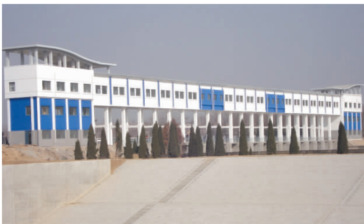
大寺水利枢纽加固扩建工程
