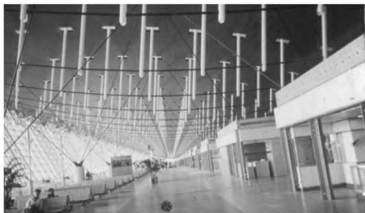
图 19 上海浦东国际机场候机楼张弦梁结构
