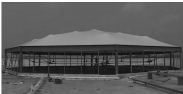
图 12 金华晟元集团标准厂房中庭索穹顶结构
