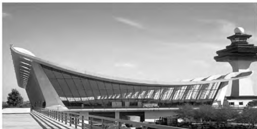
图2 华盛顿杜勒斯机场候机楼单层悬索结构
