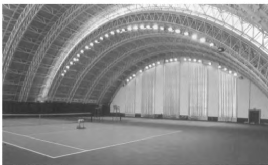
图 18 钓鱼台国宾馆室内网球场预应力装配弓式结构
