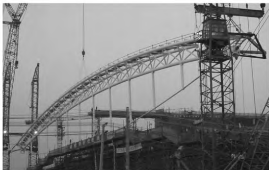
图 17 广州国际会议展览中心张弦立体桁架
