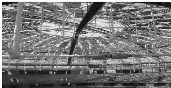
图 20 济南奥体中心体育馆弦支穹顶结构
