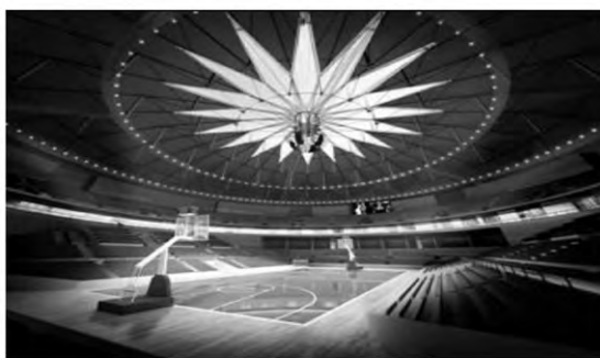
图 22 济南体育馆索穹顶—网壳结构方案
