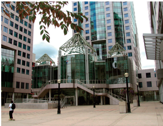
图1-4 钢骨架承重的某广场小建筑
