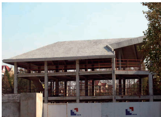
图1-1 某建筑结构系统封顶阶段
