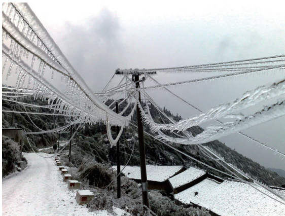
图1-13 因受力均匀仍处于平衡状态的电杆
