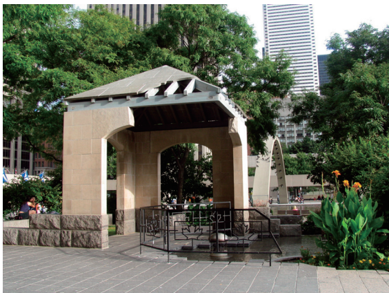
图1-5 砌体墙承重的某绿地小品
