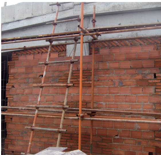
图1-17 某建筑物的砌体填充外墙
