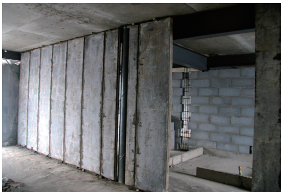
图1-19 某建筑物的轻质内隔墙
