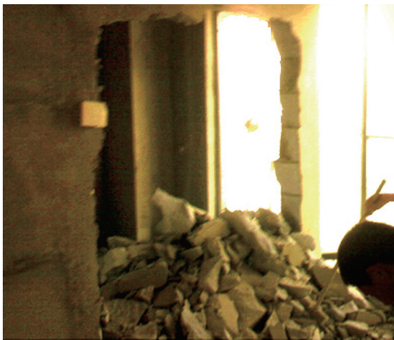
图1-15 拆除墙体前应判断是否承重墙
