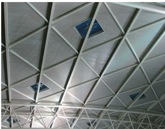
图1-11 水平结构系统需要加强刚度的实例
