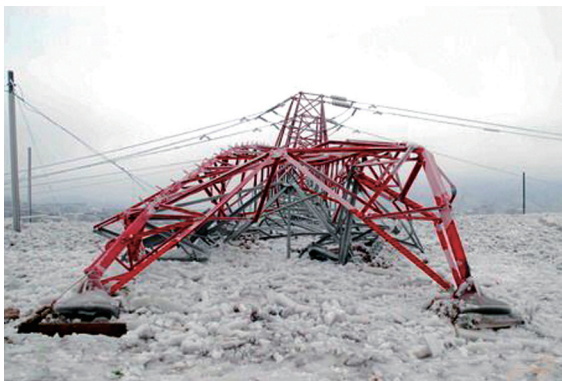
图1-12 雪灾中因失稳而倒塌的电缆塔
