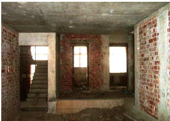
图1-3 砌体墙承重的住宅室内
