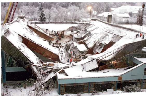
图1-6 某室内滑冰场的屋顶因结构强度不足以抵抗屋面荷载造成坍塌
