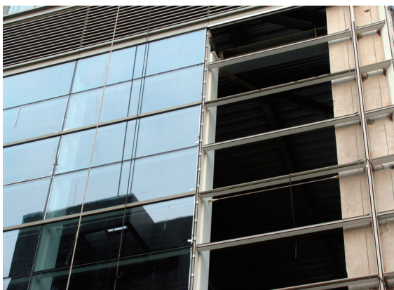
图1-18 某建筑物的玻璃幕墙
