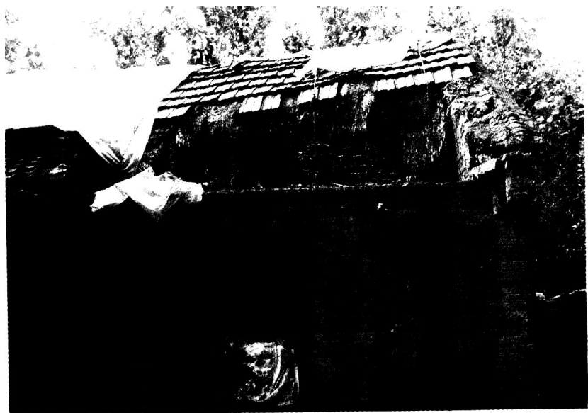
20 年的老屋虽然修补了无数次还是倒塌了
