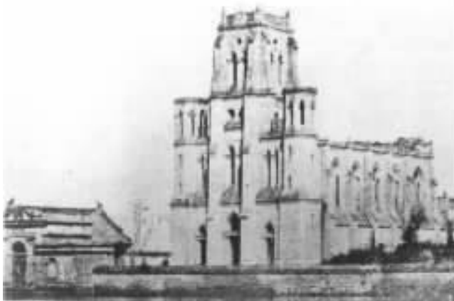
1861 年 8 月在三岔河口崇禧观原址上建成的望海楼教堂
