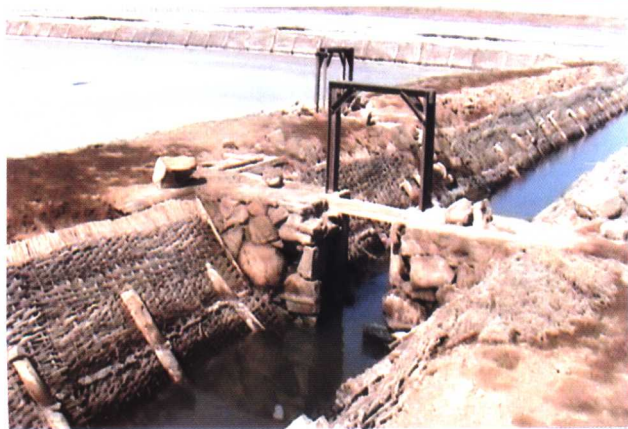
在湖岸 上新建滩晒 池输卤沟
