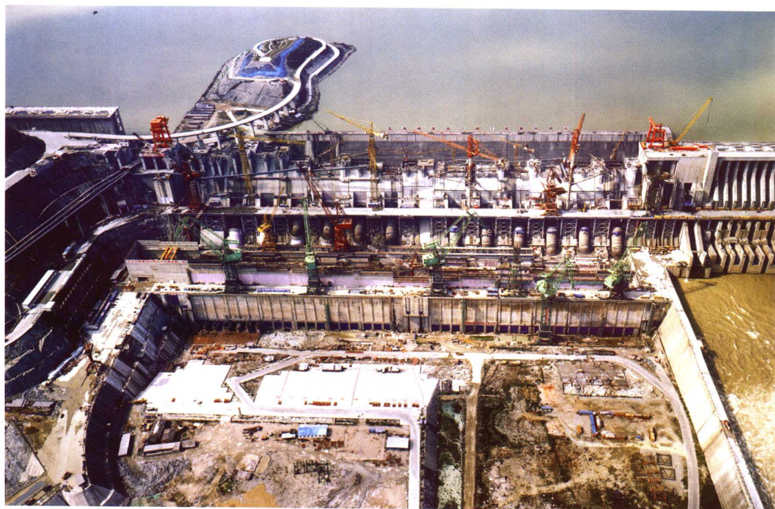
三峡水电站右岸厂房施工现场
