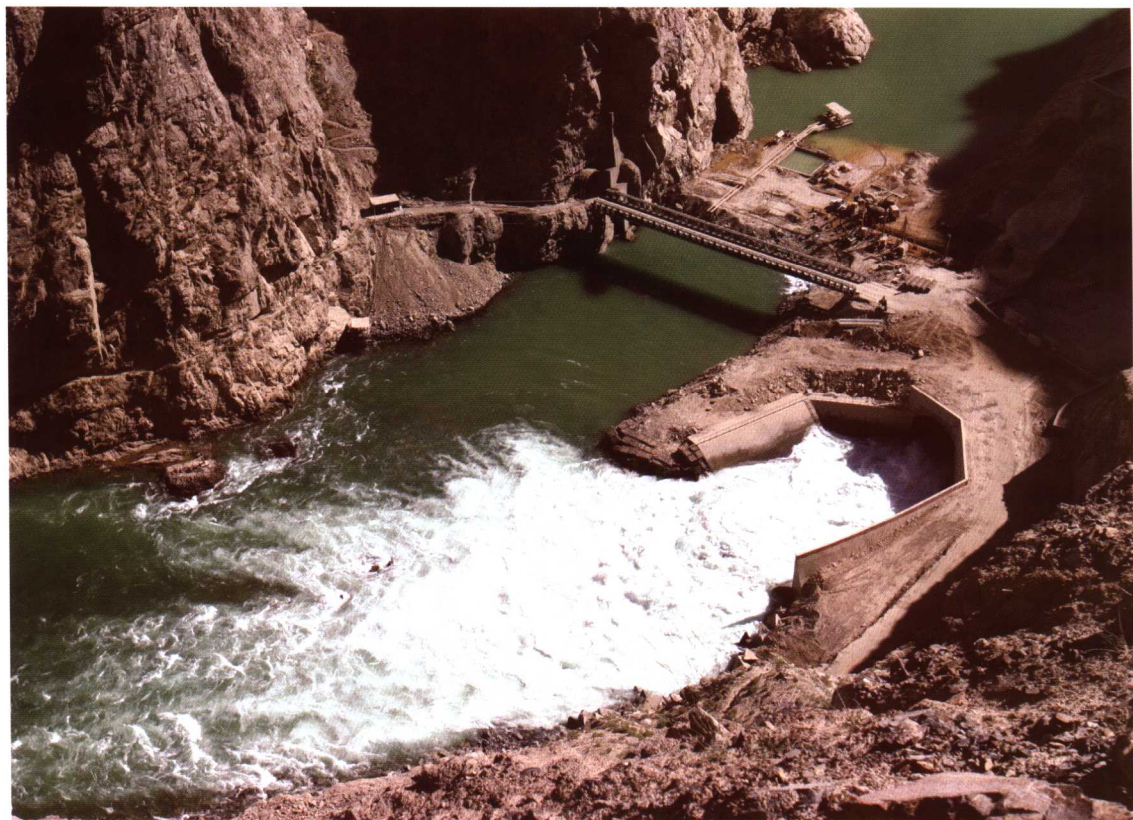
拉西瓦水电站导流洞
