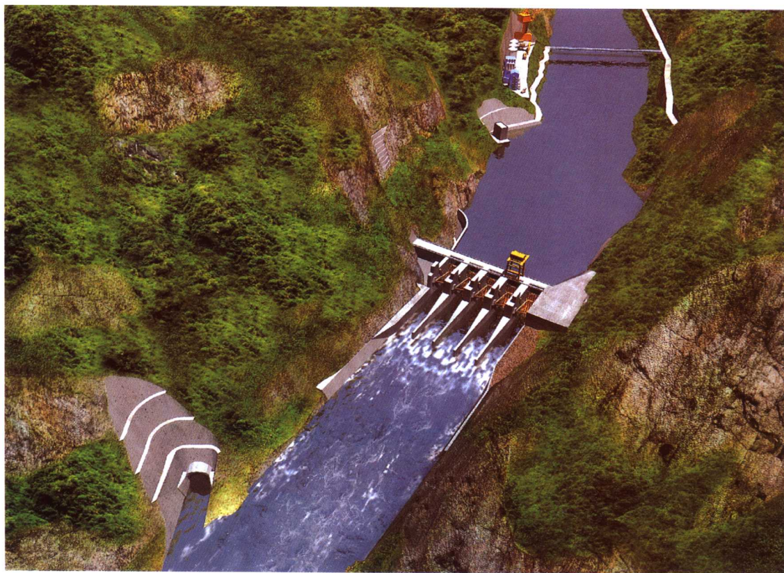
锦屏二级水电站首部拦河闸坝鸟瞰图
