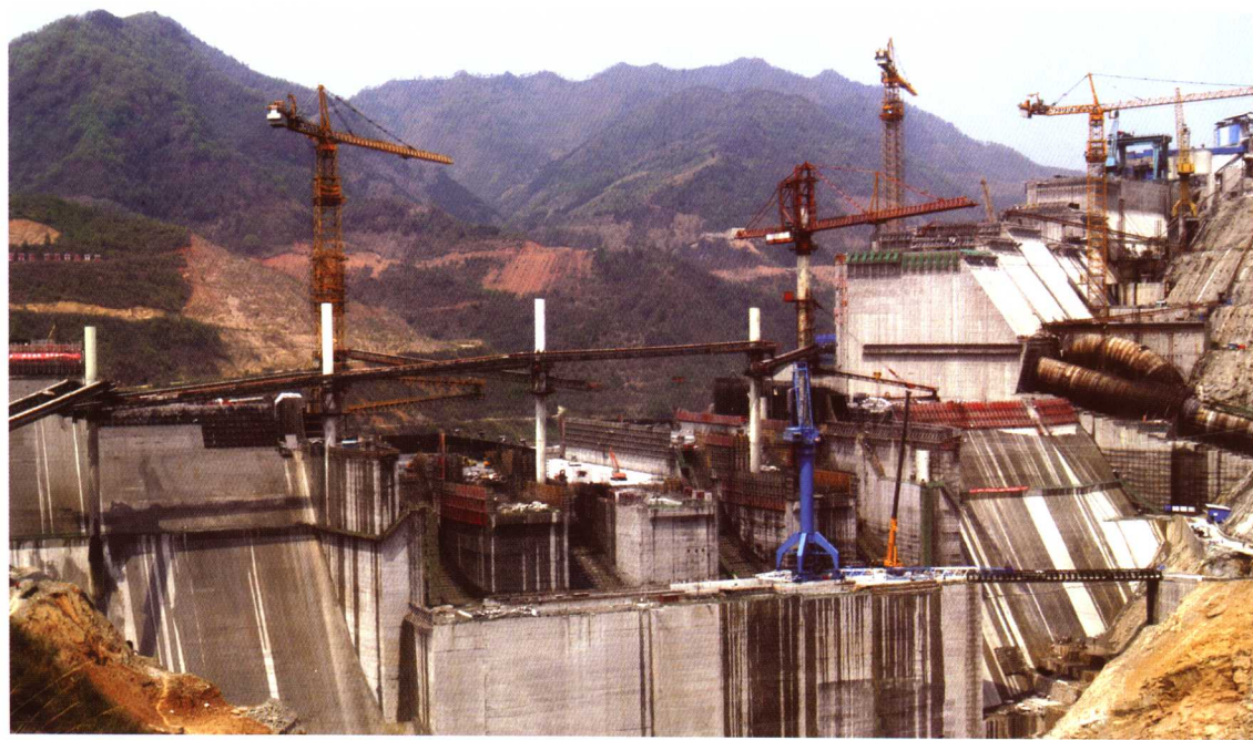
龙滩水电工程大坝施工面貌
