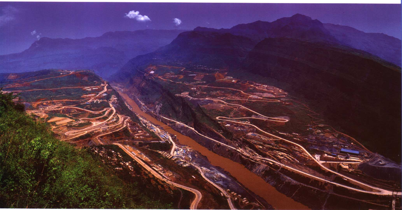
溪洛渡水电站施工现场
