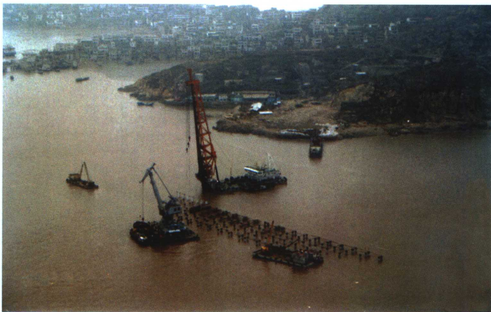
建设中的码头
