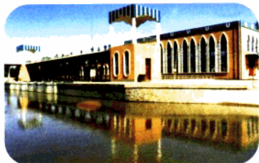
盐环定扬水工程二泵站
