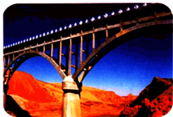
宁夏扶贫扬黄工程红寺堡洪沟渡槽
