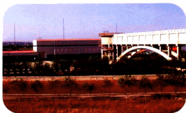
宁夏扶贫扬黄工程黄河泵站
