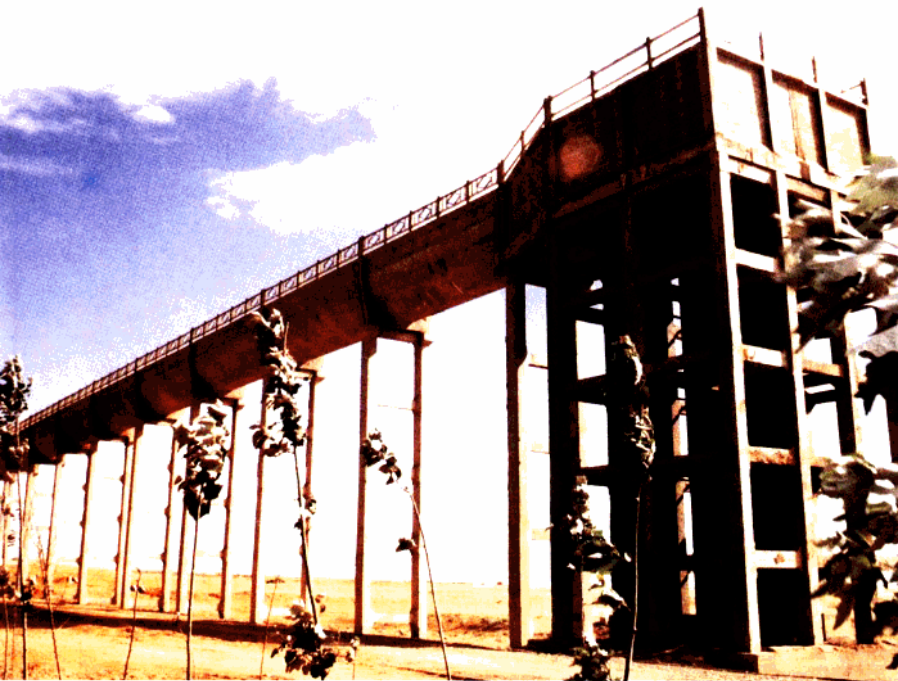
盐环定扬水工程二泵站渡槽
