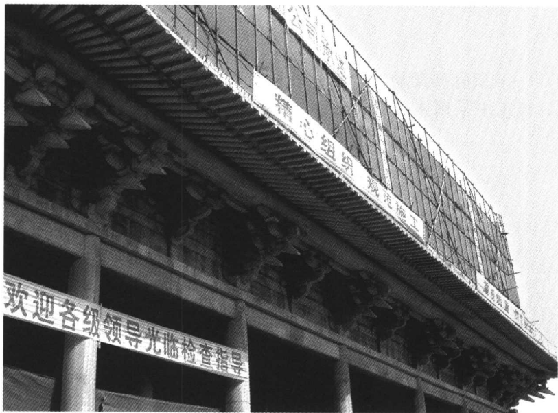
图 1-2 混凝土施工效果
