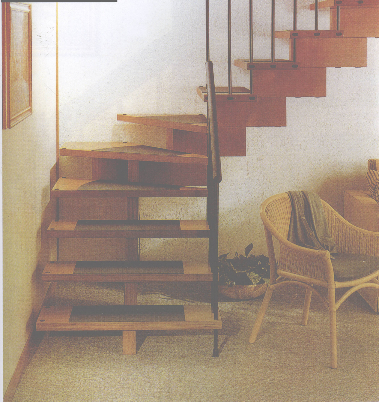
■ 踏步板的设计既具装饰作用又可以抗疲劳耐磨损。
