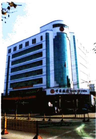
中行郾城支行办公大楼
