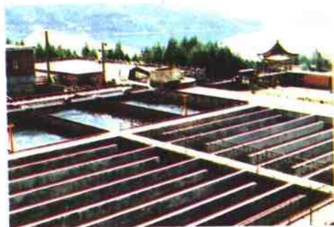
信阳市水厂气浮池
