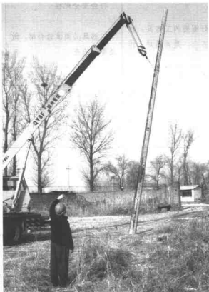
图 1-1-1 立杆作业过程
