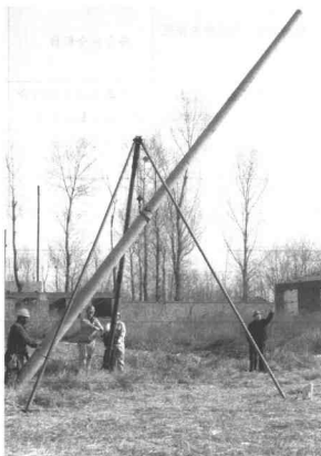
图 1-2-1 立杆作业过程
