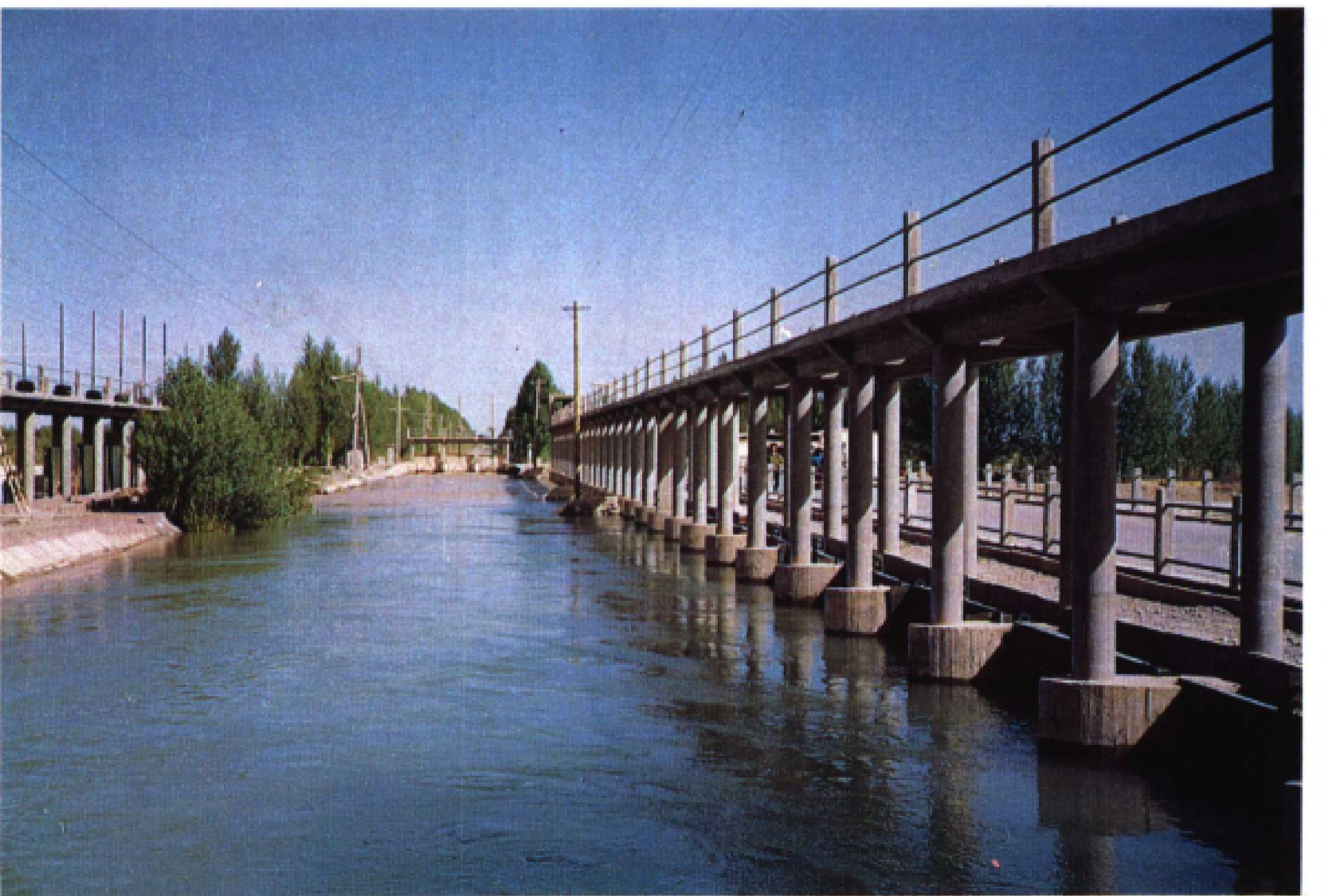
西干渠平交道
