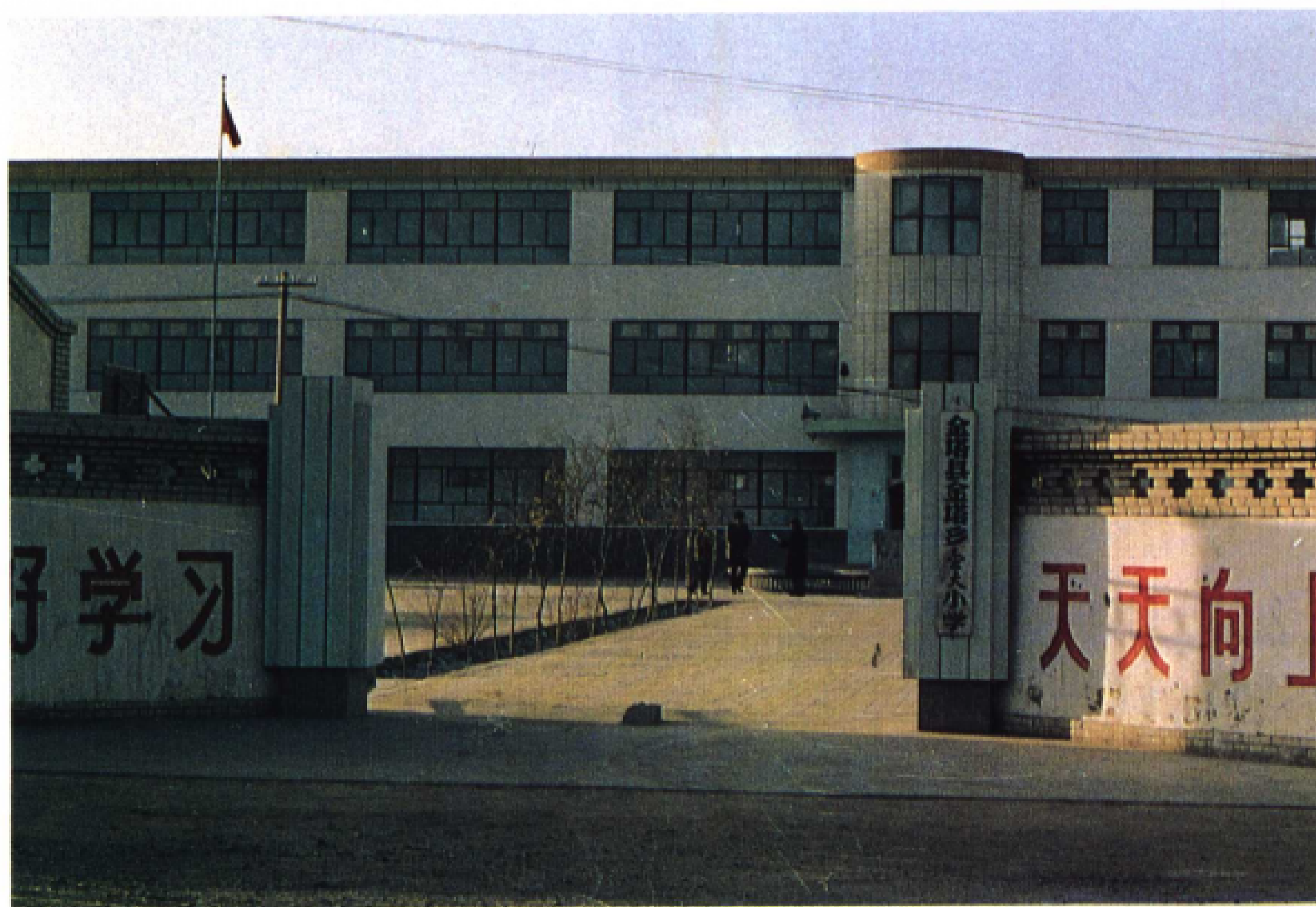
金塔乡金大村小学教学楼
