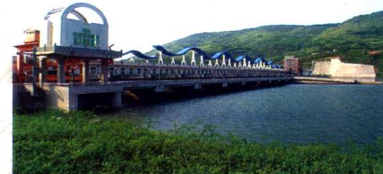
承建的浙江温州赵山渡水利枢纽
