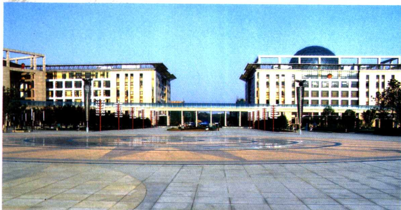
水电九局承建的贵阳市金阳新区市级行政中心人大、政协办公大楼
