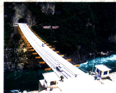
承建的索风营水电站倒张拱双车道钢索桥
