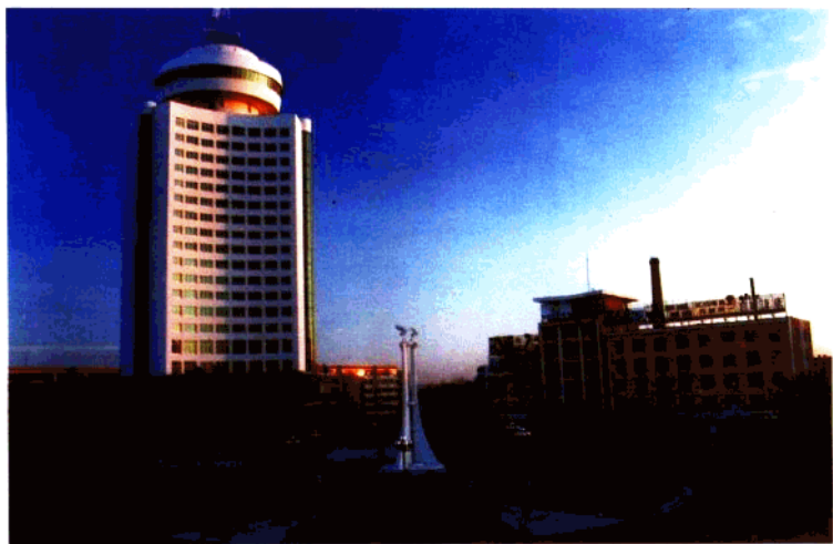
▲电业大厦与城标鹤塔
