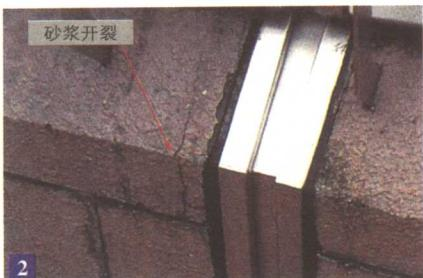
对铁件周围的裂缝也用砂浆像图1所示那样进行修补是造成漏水的原因。
