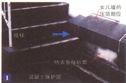
雨水从上图的箭头开始越过压住沥青防水层的砖的上部，流向防水层的端部。
