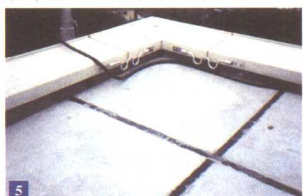
这是露缝接头的铝制压顶，在压顶中用铁件及封口处理固定防水层，但是上翻高度太低。
