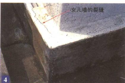
由于强烈的日晒产生膨胀及冬天的寒冷产生收缩，较差的混凝土将承受不住热胀冷缩的作用而产生如照片所示的裂缝。
