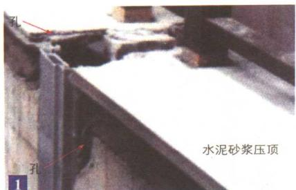
用砂浆制作的压顶。另外，伸缩缝周围的孔洞也用砂浆抹平。
