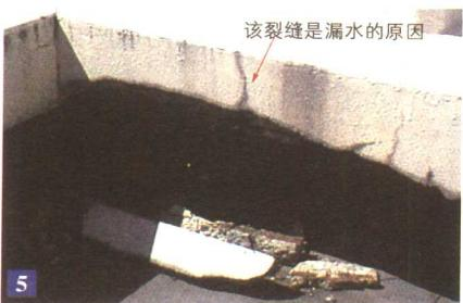
女儿墙混凝土开裂，雨水从此处渗入，钢筋锈蚀而产生膨胀，下部混凝土已产生脱落。
