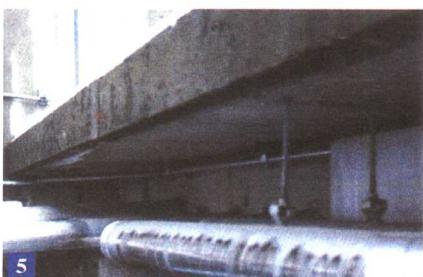
下雨天的水流情况。水流大的部分有时部分雨水超越滴水槽，但基本上能切断雨水。
