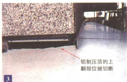
在安装时将铝制压顶的上翻部位切断。这种如果进行了封口处理无人知道的想法是很可怕的。这种敷衍了事的施工与漏水有直接关系。
