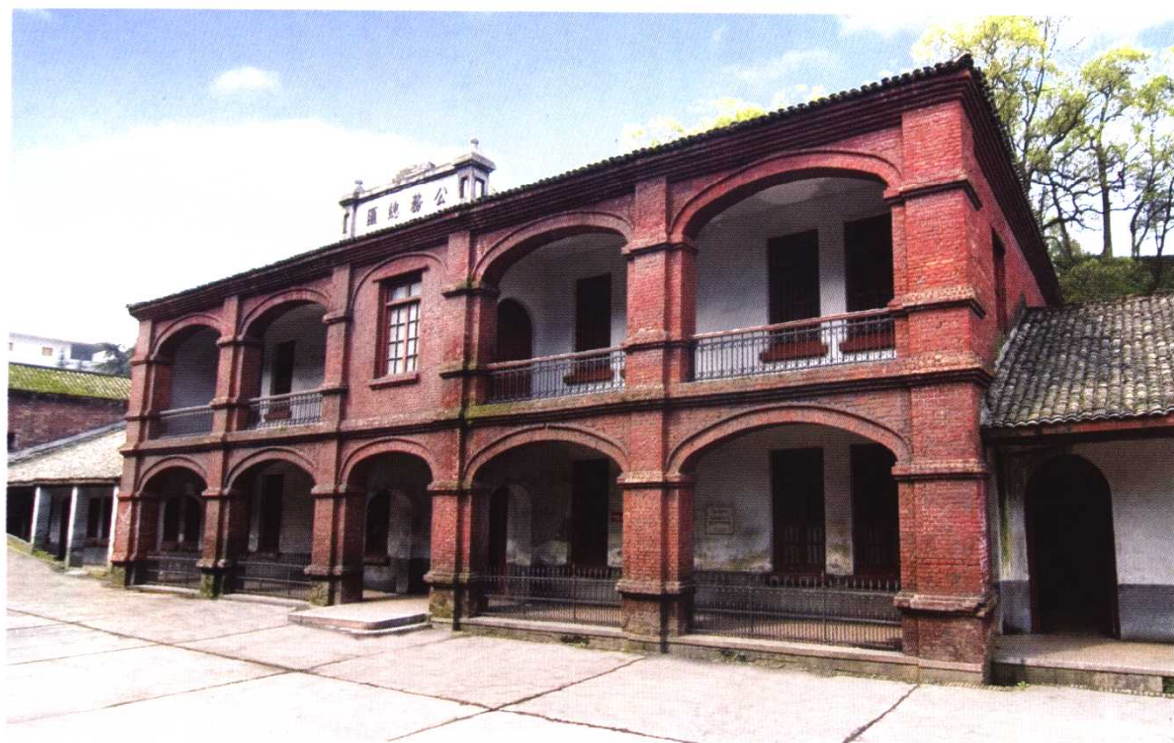
谈判大楼—矿局公务总汇大楼
