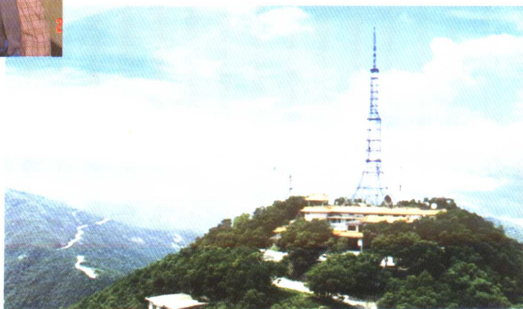
▼ 图 2.4: 俯瞰大地的电视调频发射台
