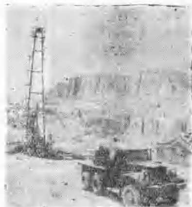
代吉斯-150 汽車改裝吊油車吊油
