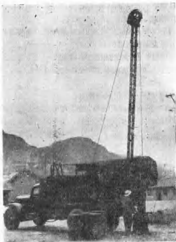
电 动 吊 油 設 备
