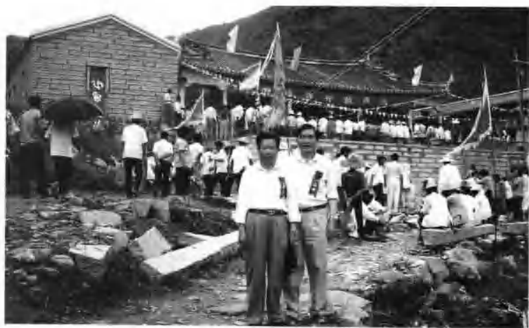
建设中的法留山清峰寺。
