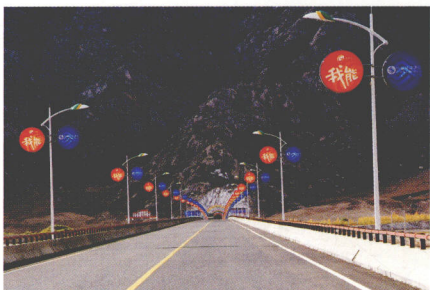
▲拉贡公路（拉萨—贡嘎机场）协荣隧道是西藏第一条高等级、大跨径隧道，在西藏公路建筑史上有里程碑意义。
