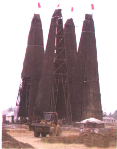
▲ 杨柳煤矿副井注浆施工
