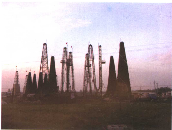
▲ 刘庄煤矿西区进风井注浆施工
