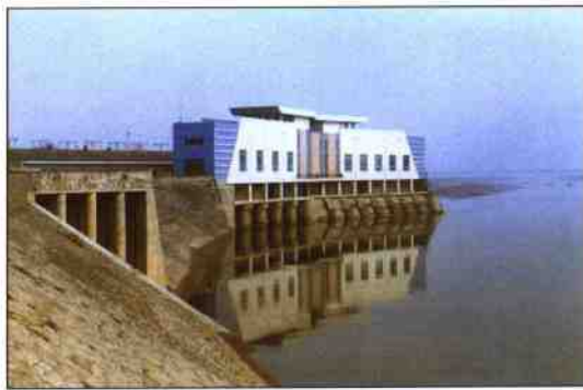
交口抽渭西楼子抽水站
