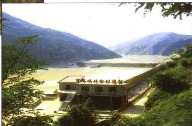
宝鸡峡引渭灌溉工程林家村渠首
