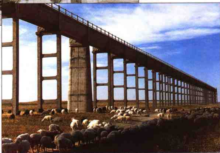
盐环定扬黄定边供水工程渡槽
