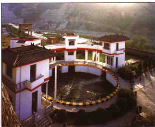
黑河引水工程蔺家湾汇流池
