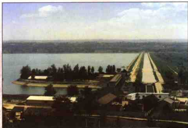
王家崖渠库结合工程
