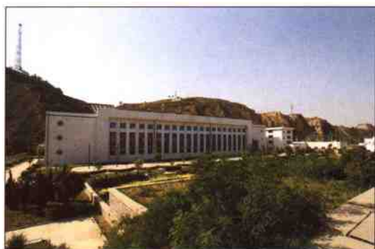
东雷抽黄续建工程北干抽水站
