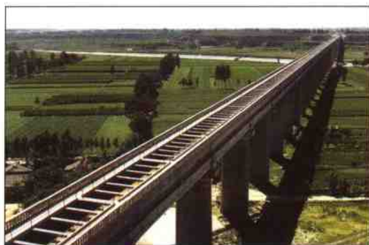
东雷抽黄续建工程洛河渡槽
