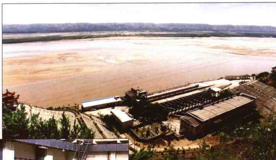
东雷抽黄工程一级泵站
