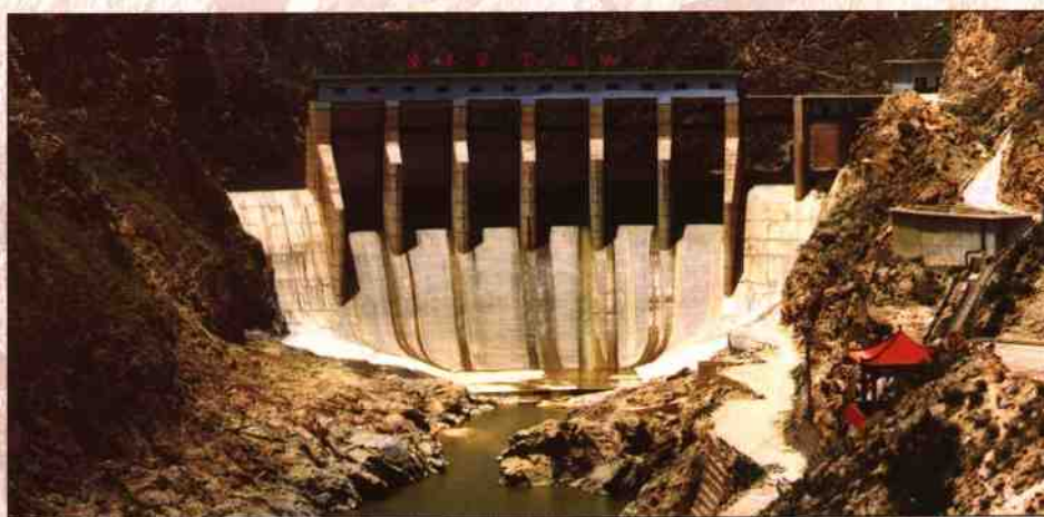
泾惠渠渠首加坝加闸工程
