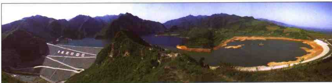
黑河金盆水利枢纽工程全景
