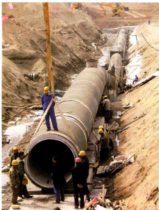
引石过渭工程管道安装施工现场
