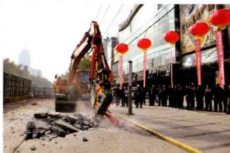
咸阳市城区秦皇路段供水管网改造工程
