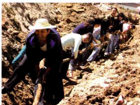
市西郊给水工程筹建处抢修供水管道
