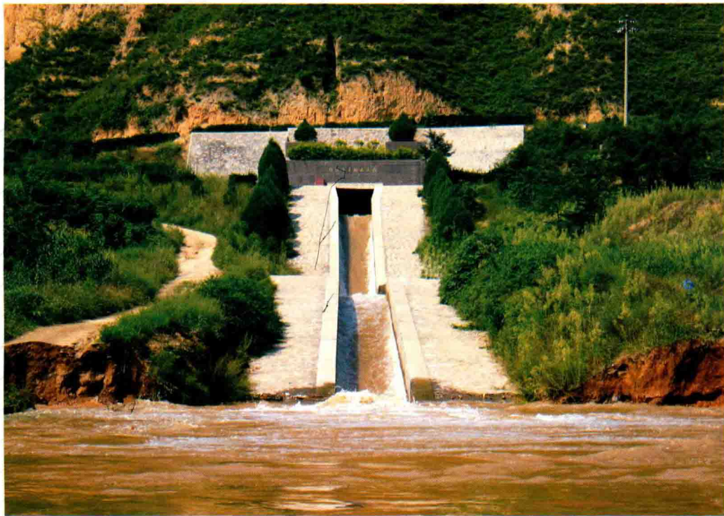
羊毛湾水库引冯济羊工程输水洞
