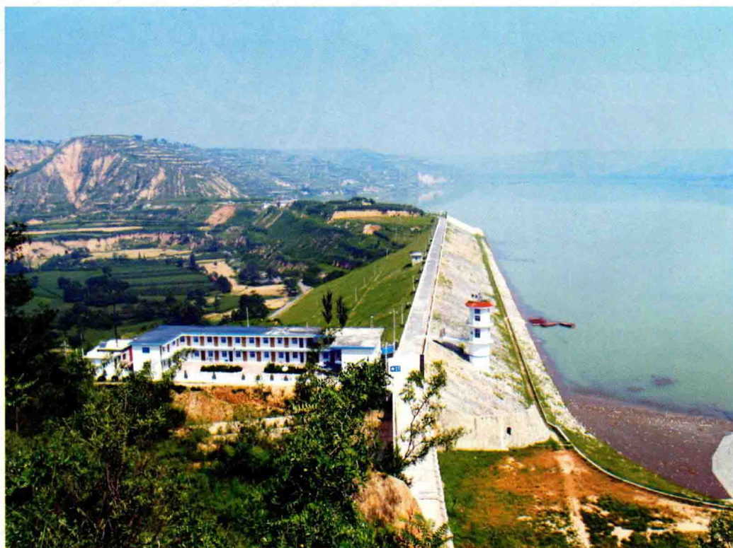
除险加固后的羊毛湾水库
