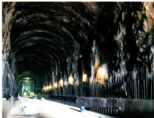
建设中的亭口水库泄洪排砂洞工程 建设现场
