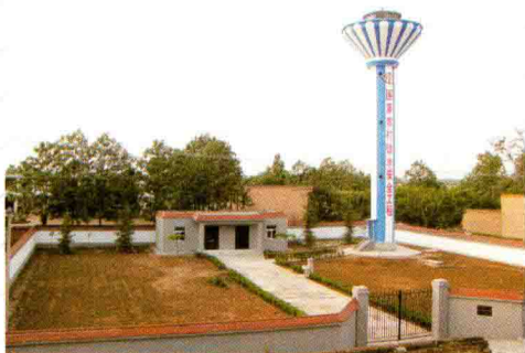
渭城区北杜镇靳里村农村人饮工程
