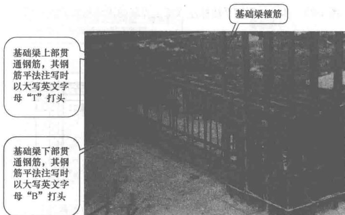
图 1-21 基础梁钢筋安装效果图
