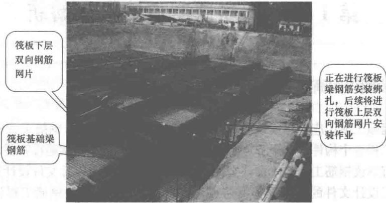
图 1-3 梁板式筏板钢筋结构安装绑扎
