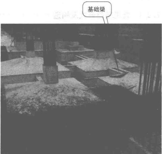
图 1-5 独立基础混凝土成型效果
