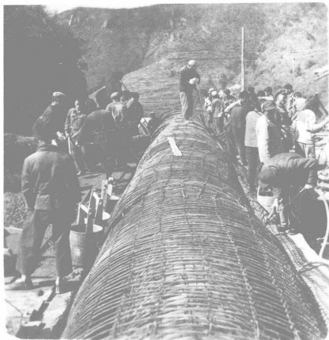
1964 年,郴州农村兴修水利工程场景。
