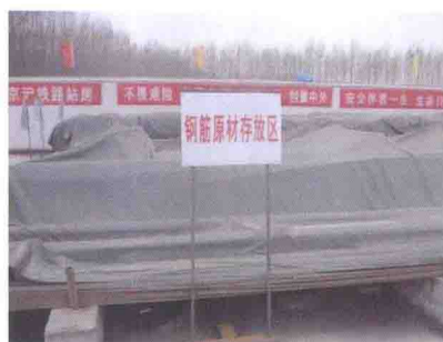
图 3.2.3-2 钢筋现场防雨布覆盖
