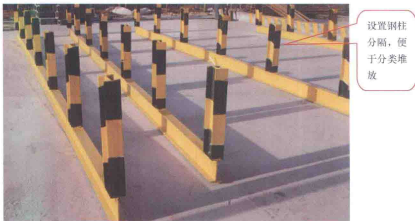
图 3.2.1-1 钢筋现场分类堆放场地
