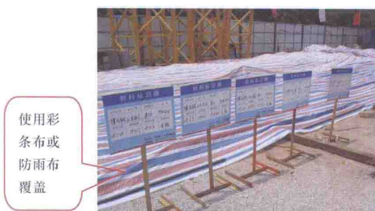
图 3.2.3-1 钢筋现场彩条布覆盖
