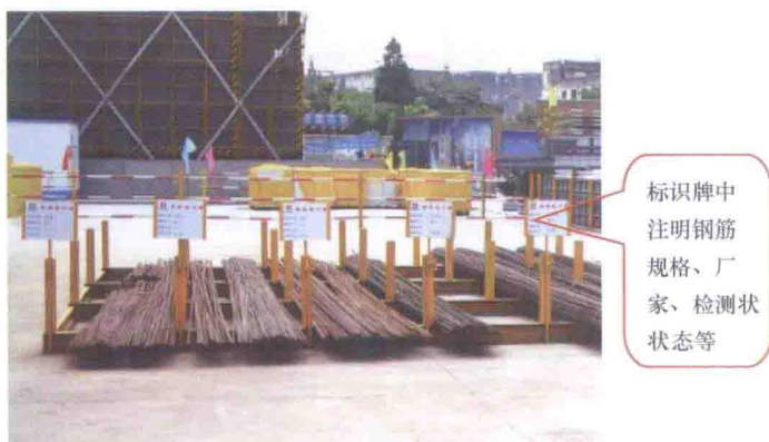
图 3.2.2-1 钢筋现场挂牌标识
