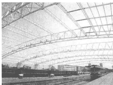
(c) 管桁架结构
