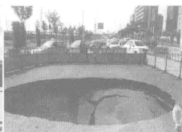
(d) 上海市浦东新区道路塌陷
