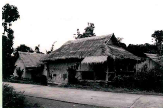
▲ 傣族近期内廊式民居（茅草屋面）
