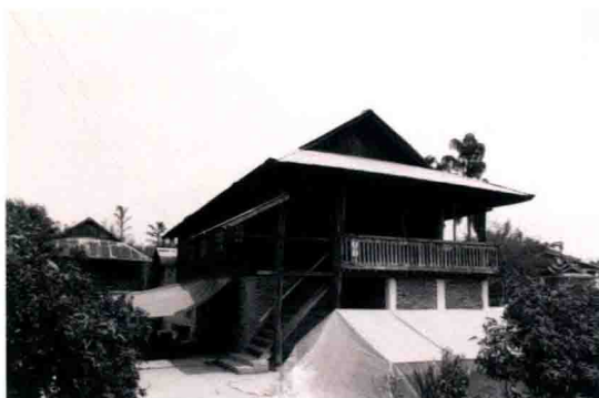
▲ 傣族近期内廊式民居（铁瓦屋面）
