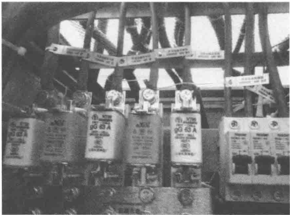
图 1-2 波分传输设备电源标签
