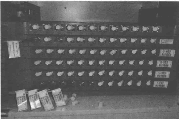
图 1-4 ODF 端口编号标签
