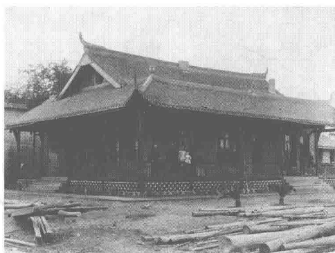
加拿大传教士在成都的第一栋房屋（重新修缮） 拍摄时间：1896年 照片档案号：1999.001P/2976
