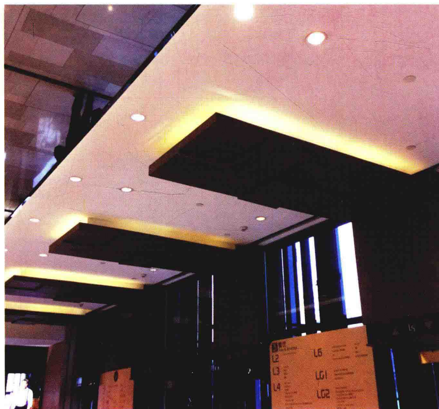
上海环贸广场电梯厅吊顶
