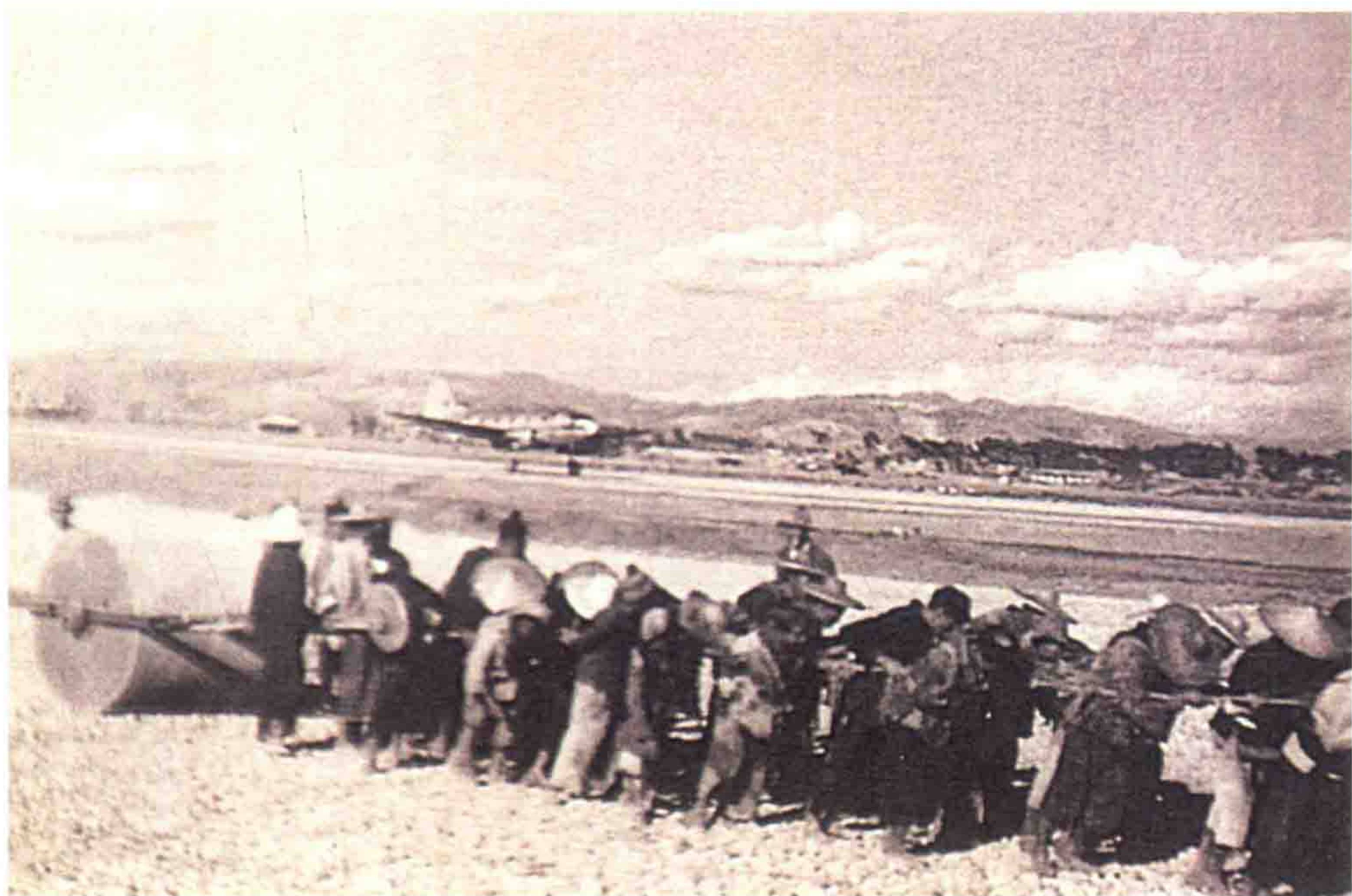
1943年参加修建黄平旧州抗战机场的民工齐心协力牵拉着夯土石滚的情景
