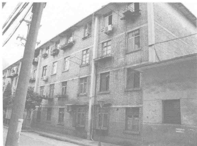
图 1-1 某四层砌体结构抗震加固后,在地震中房屋完好
