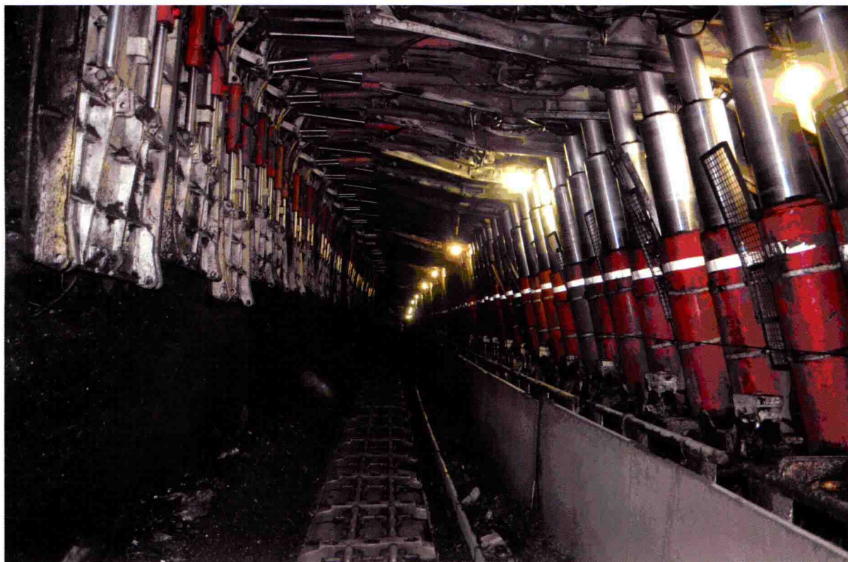
淮南矿业集团谢桥煤矿 1161（3）大采高工作面
