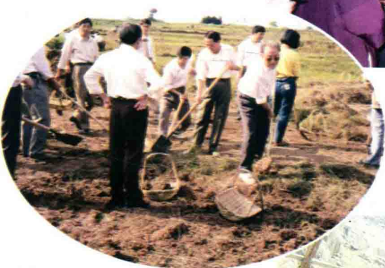
1993 年 10 月 6 日，参加金温铁路金华南站建设工地劳动
