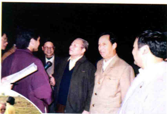
1993 年冬天，在金温铁路婺城区段，慰问挑灯夜战的建设者
