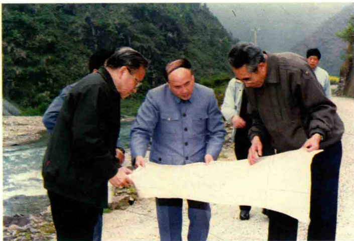
1991年4月11日，陪同李泽民同志视察沙畈水库坝址
