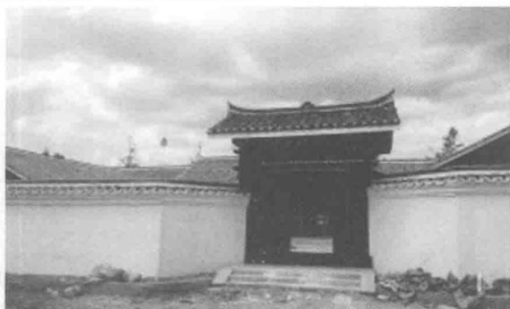
正在修建的溆浦县舒新城纪念馆一角
