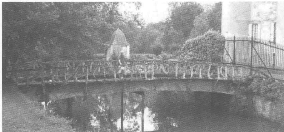
图 1-3 约瑟夫·莫尼埃主持建造的首座钢筋混凝土桥
