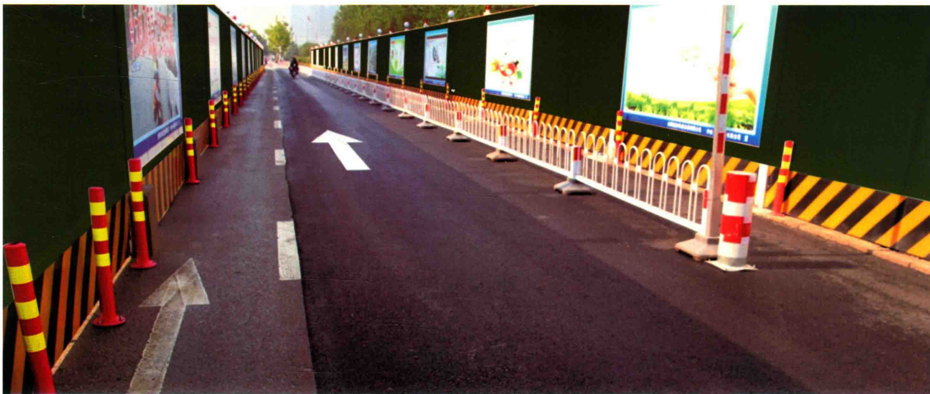
▲ 临时围挡实景图
