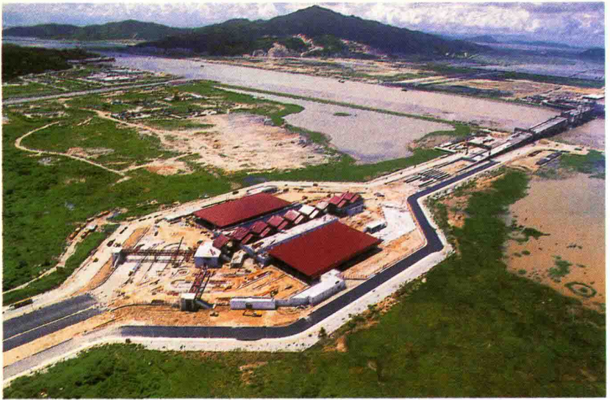
趕在1999年12月20日回歸前通車的蓮花大橋，將接駁廣珠準高速鐵路和廣珠高速公路。
