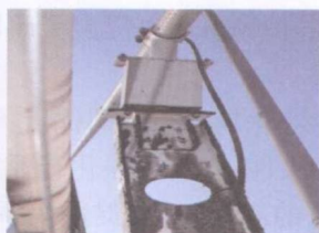
b) 阻尼器损坏导致拉索振动异常
