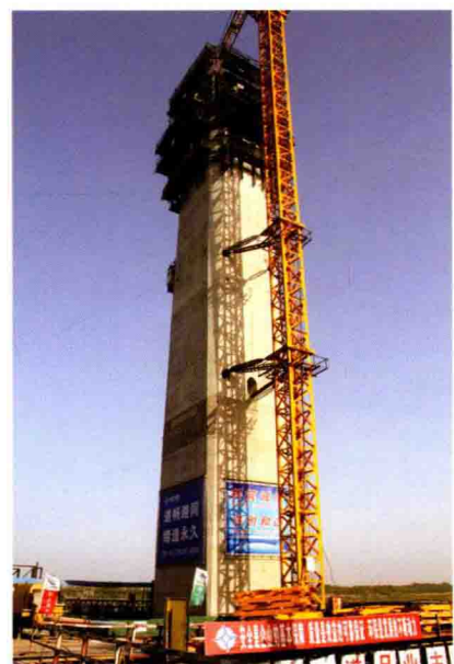
利用亚洲开发银行贷款 徐明高速公路项目大桥主塔 （2012 年 摄）
