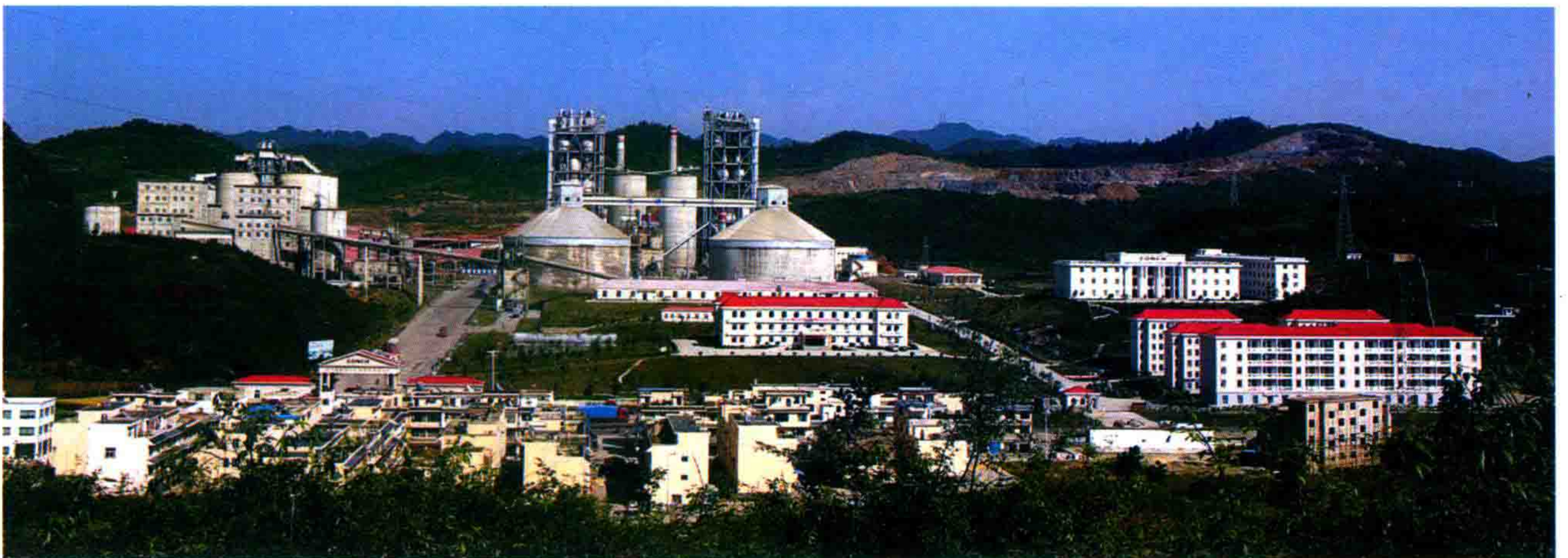
位于站街镇茶林村的贵阳海螺水泥厂
