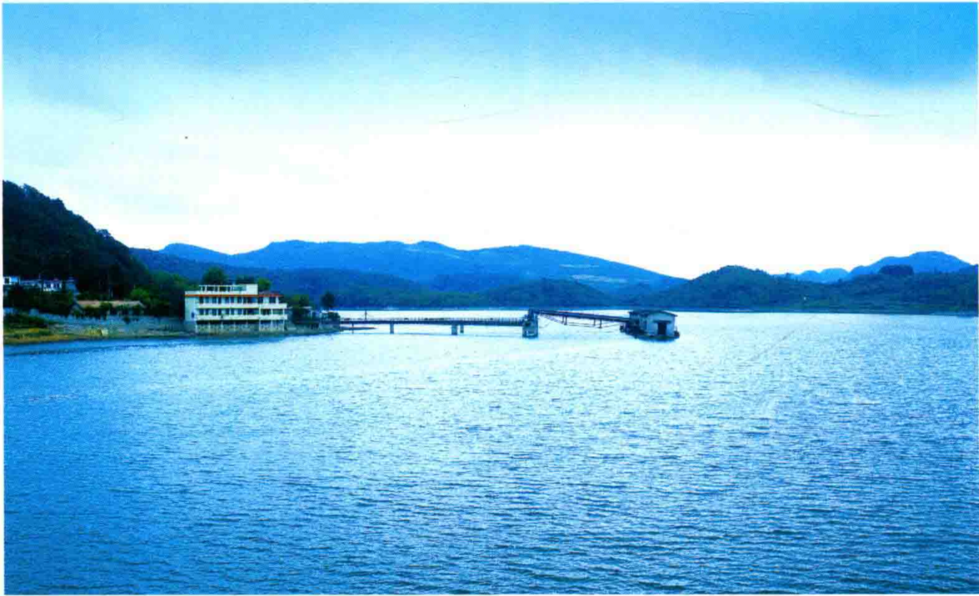
位于站街镇小河村的小河提灌站
