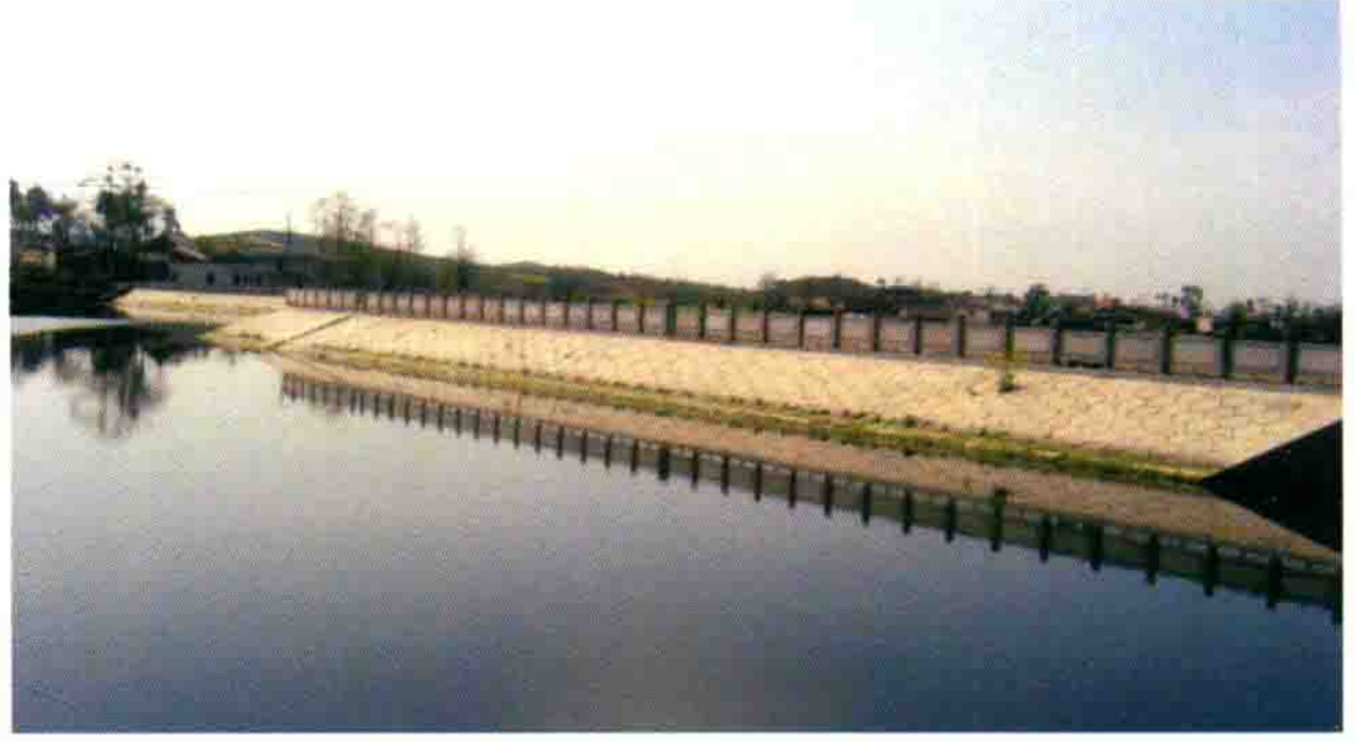
中八水库大坝
