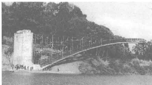
图 1.1 某桥梁平转体开始
