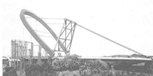
图 1.4 光谷跨外环桥梁索塔竖转施工
